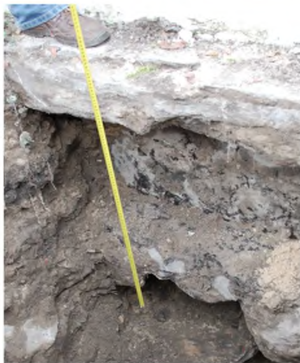
Fot.3,4. Ściana fundamentowa – brak izolacji przeciwwodnych; nieregularny kształt muru
