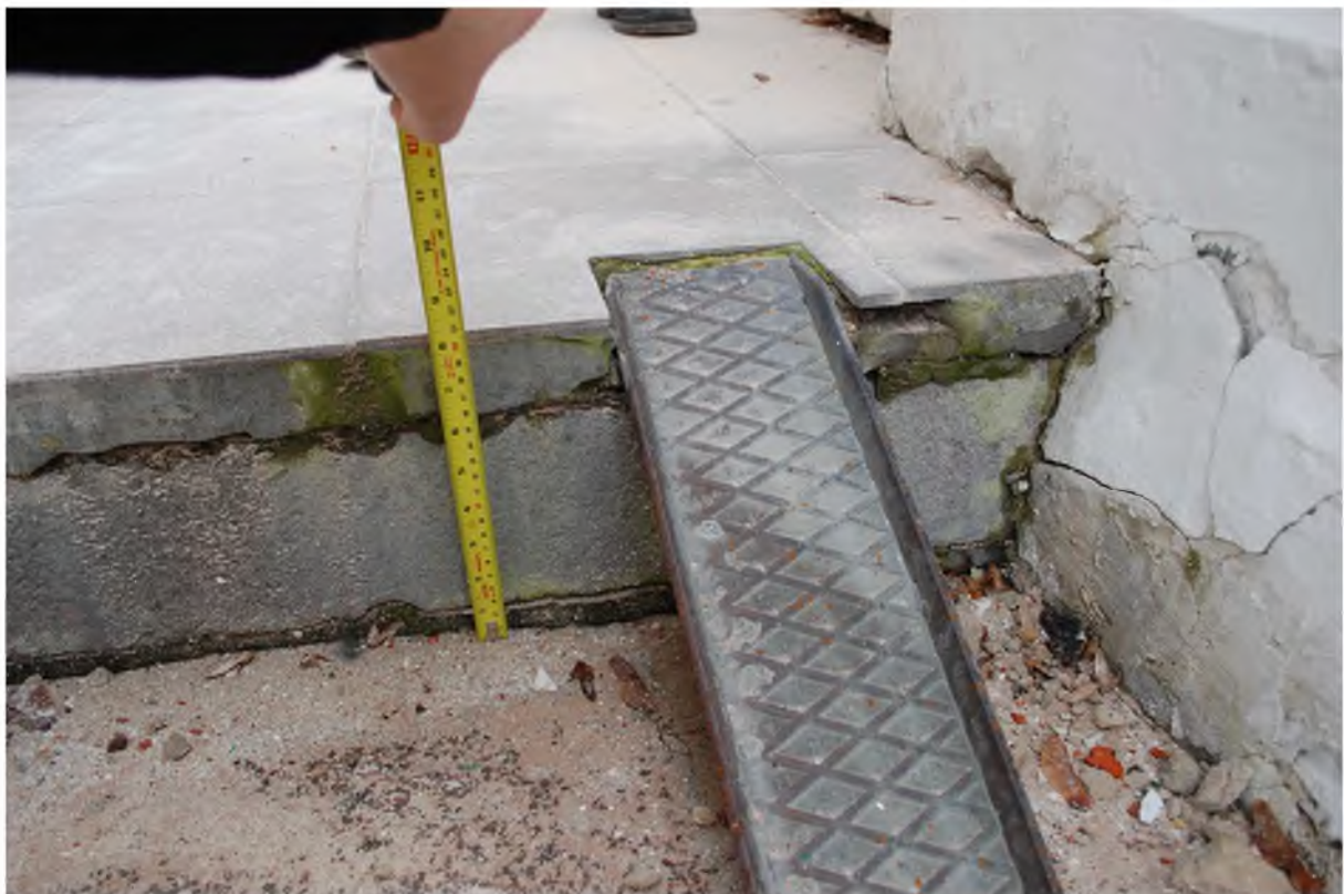
Fot.12 Schody – posadzka tarasu
