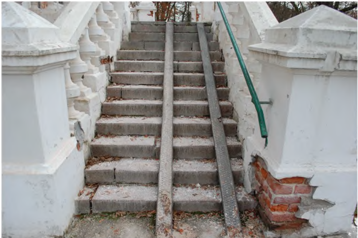
Fot.10 Schody – strona północna
