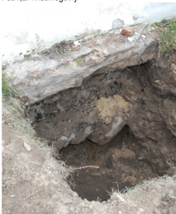
Fot.3,4. Ściana fundamentowa – brak izolacji przeciwwodnych; nieregularny kształt muru
