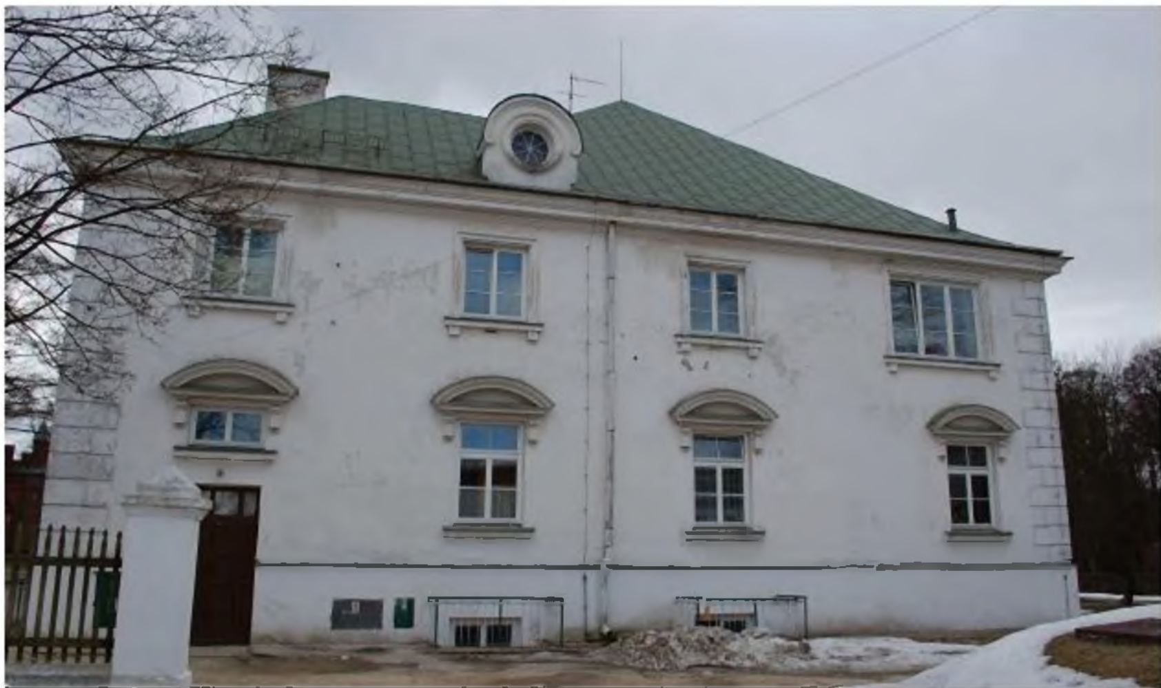
Widok elewacji bocznej, północnej
