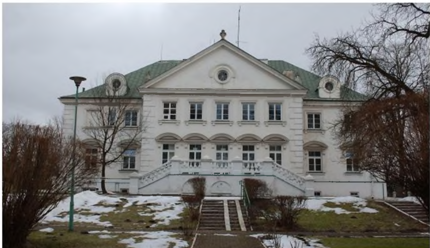
Widok elewacji ogrodowej, zachodniej
