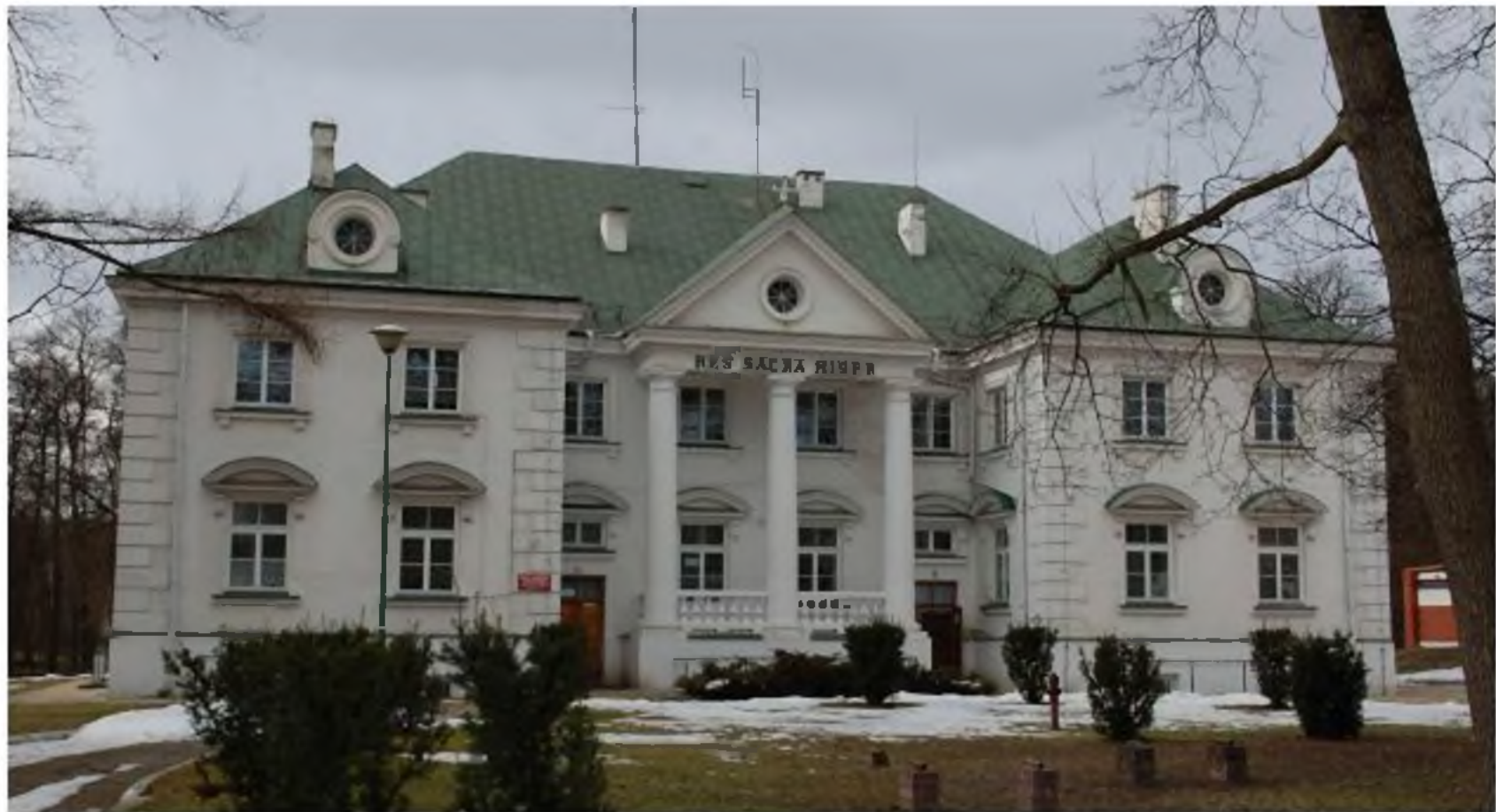
Widok elewacji frontowej, wschodniej
